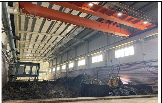
油泥砂暂存库内固态油泥暂存池
