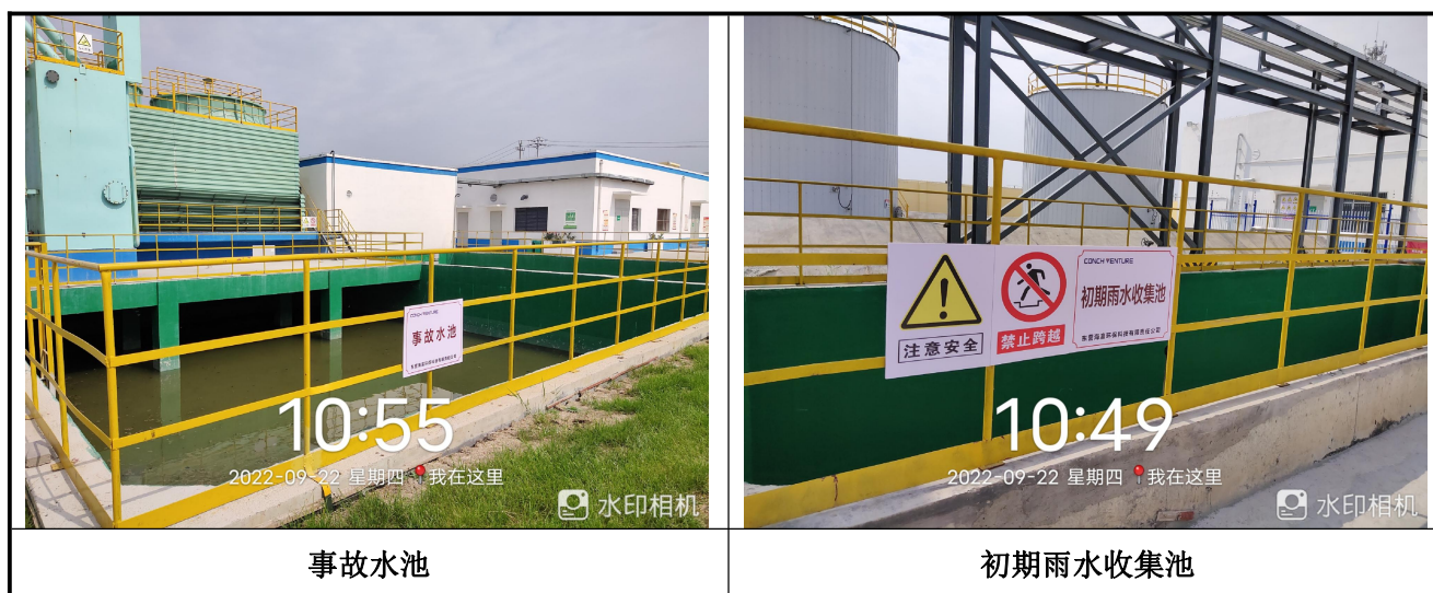
图 4-6 事故水池与初期雨水池照片
