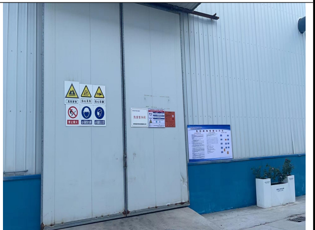
1#车间西侧危废暂存间
