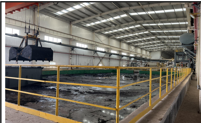
油泥砂暂存库内液态油泥暂存池
