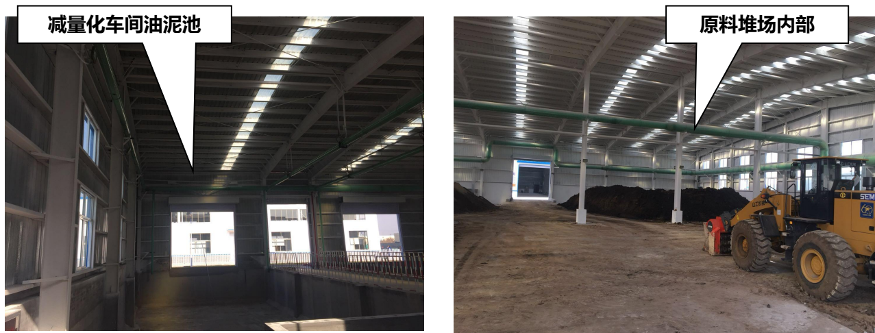
图 3.3-2 减量化厂房油泥池、油泥堆场实际建设情况
