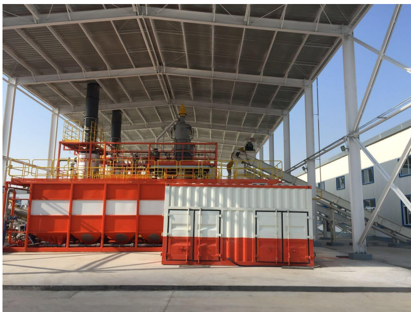
图 3.4-2 热相分离处理厂房设备（全景）实际建设情况
