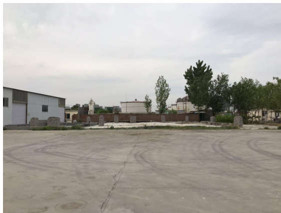
老厂区储存区现状
