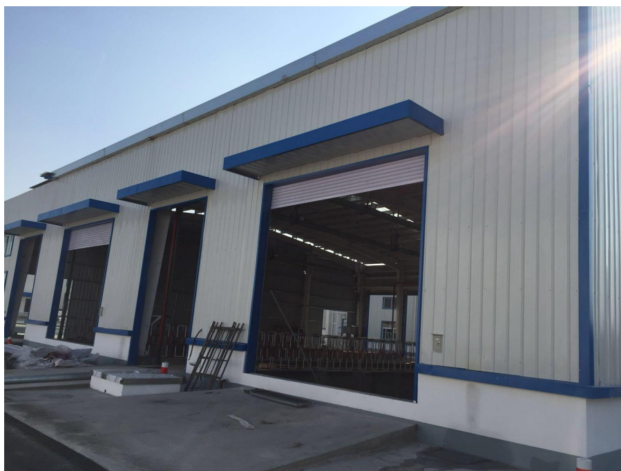
图 3.4-1 减量化处理厂房（北侧）实际建设情况
