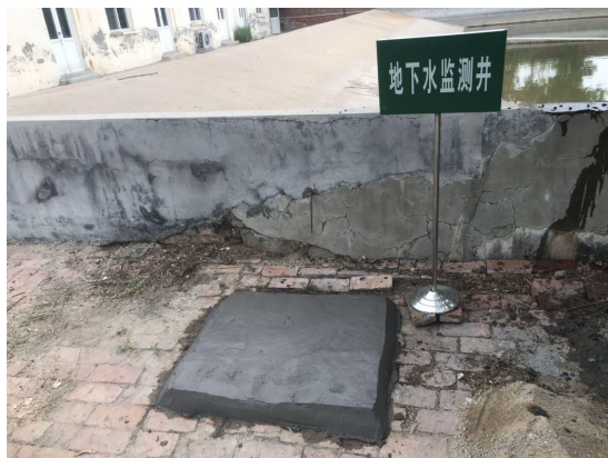
地下监控井封堵后现状
