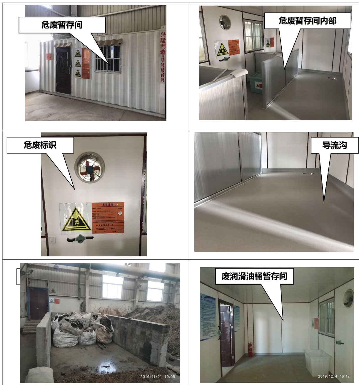
图 4.2-6 危废暂存间设置情况
