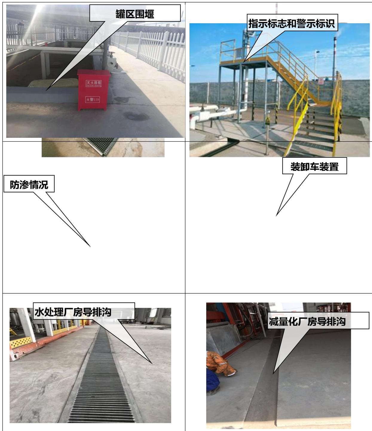
图2.7-7 装置区导排沟及罐区围堰设置情况
