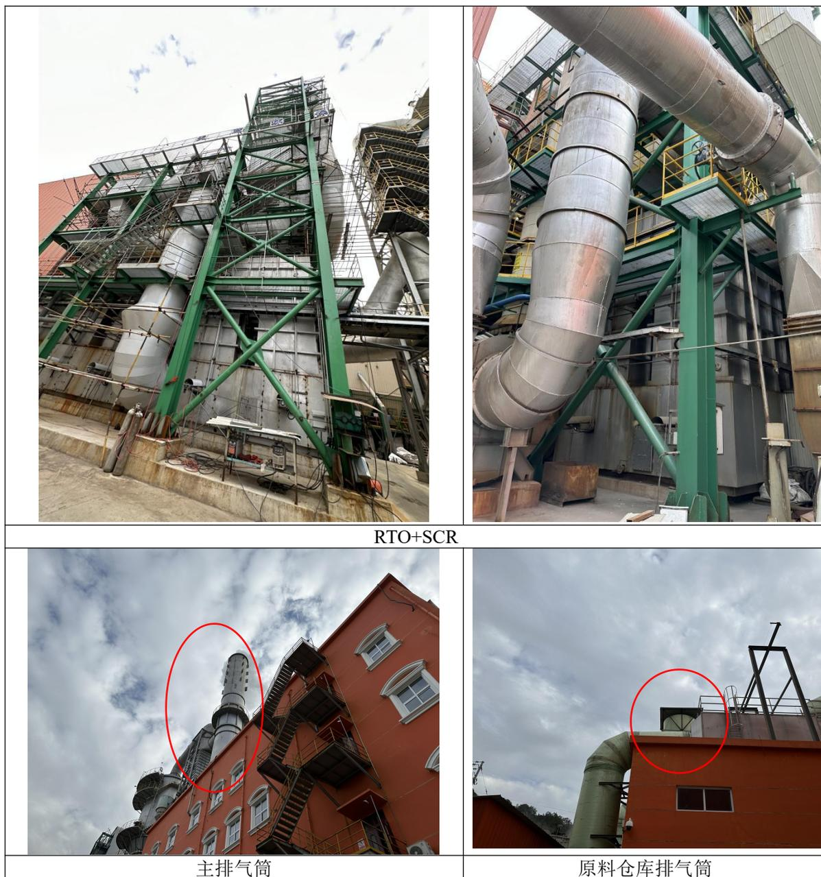
图 4.1-2 废气处理设施现场照片
