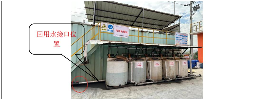
图 2-3 生活污水排放口、雨水排放口及回用水接口位置现场照片
