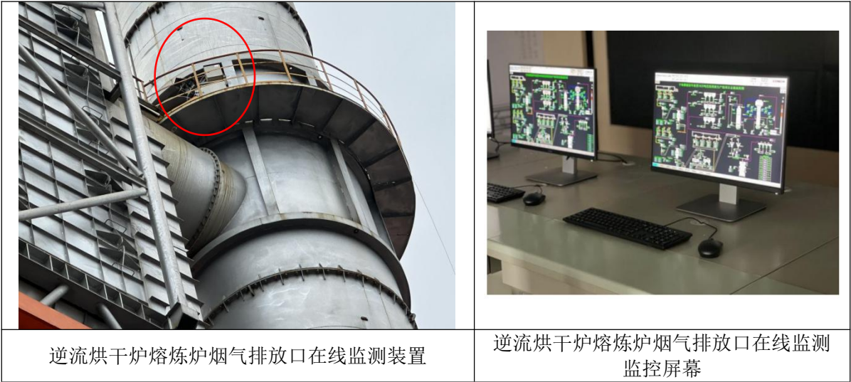
图 4.2-4 废气在线监测现场照片
