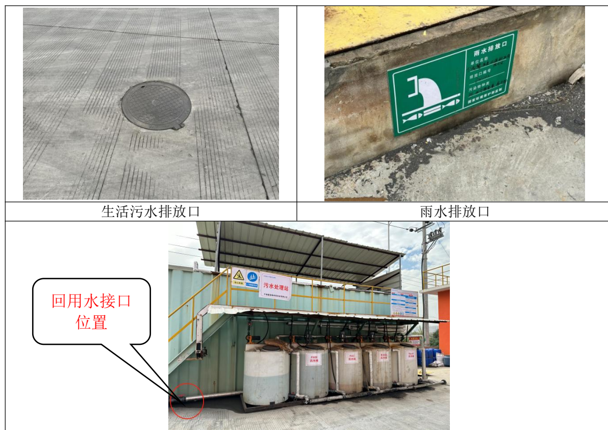
图 4.2-3 生活污水排放口、雨水排放口及回用水接口位置现场照片
