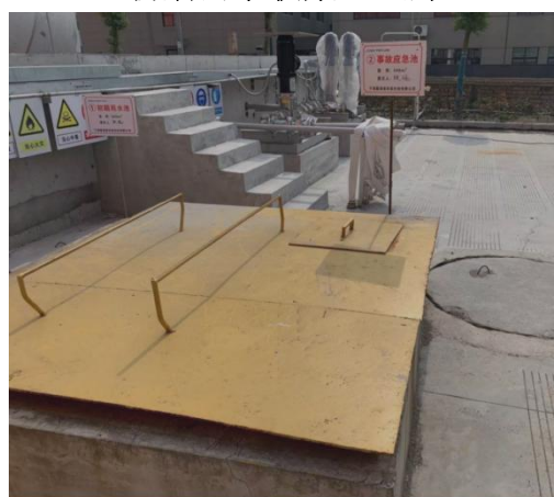
事故应急池照片
