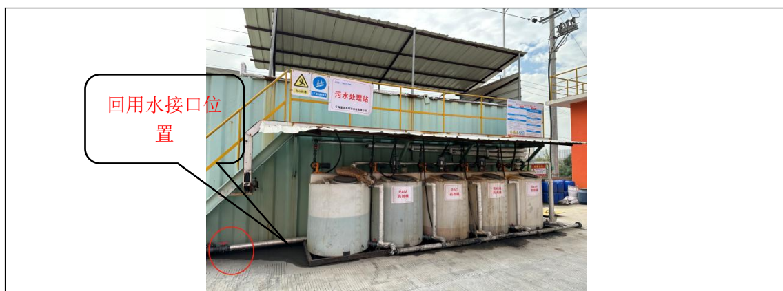
图 3-3 生活污水排放口、雨水排放口及回用水接口位置现场照片
