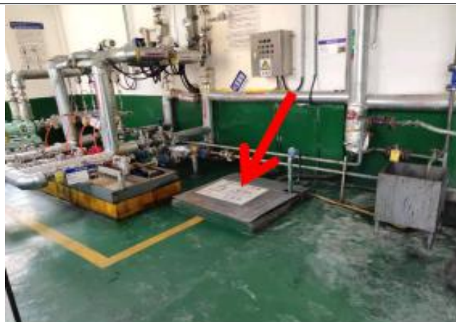
废液间 20 方应急池
