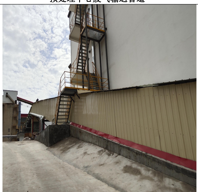
无机输送廊道
