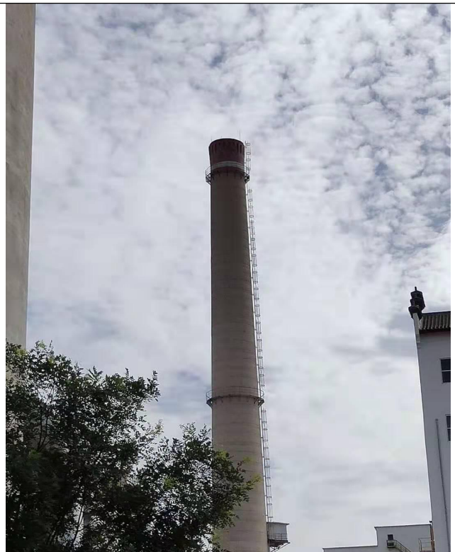
水泥厂窑尾排放口
